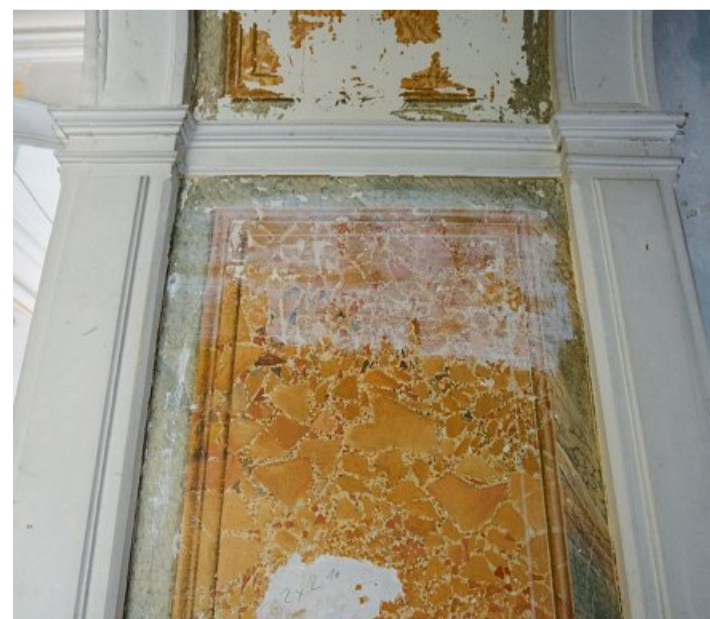
Sensationelle Entdeckung: An dieser Stelle im Korridor ist in einmaliger Weise die Marmorstruktur auf der bemalten Wand zu erkennen.
