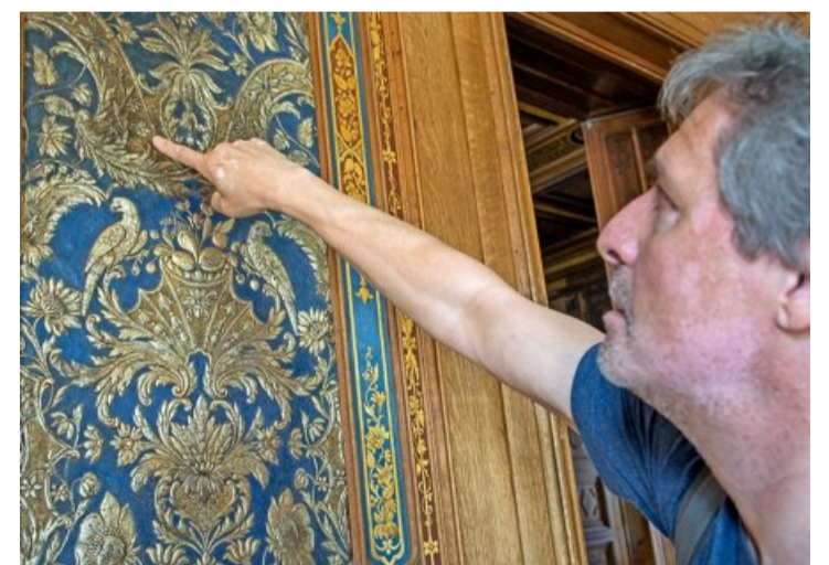
Ledertapeten und Lederimitationen: Denkmalpfleger Michael Gerber zeigt im grossen Saal im Erdgeschoss auf Verfärbungen.
